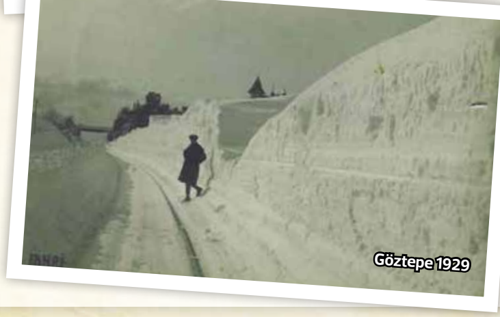
Demir yolu temizleme çalışmaları
